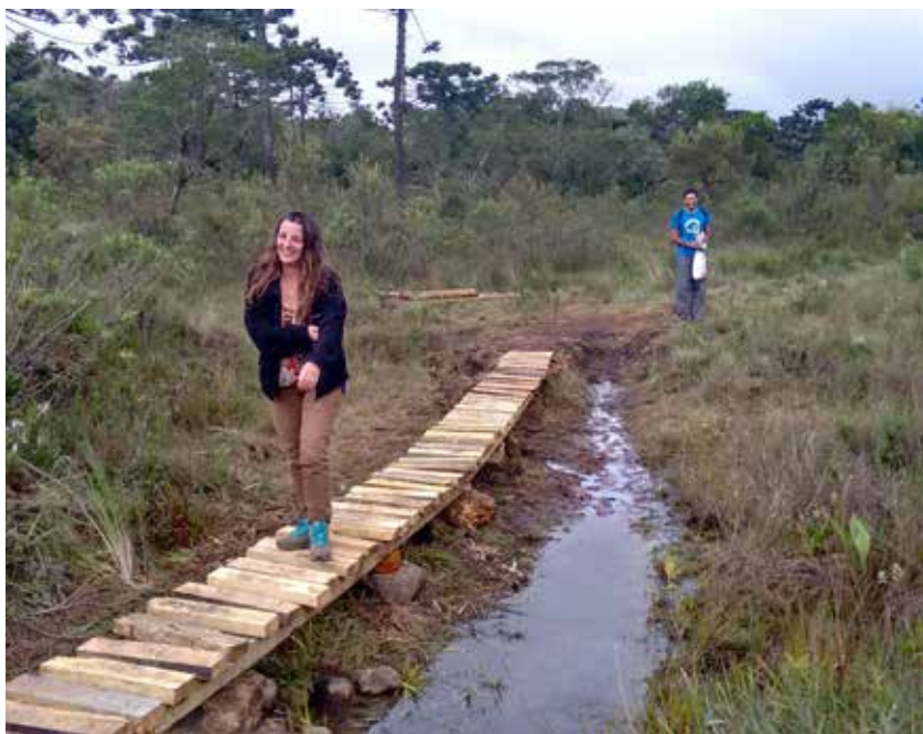
Clarice testando a ponte, ainda inacabada, sobre um charco, obra da equipe do PNT
