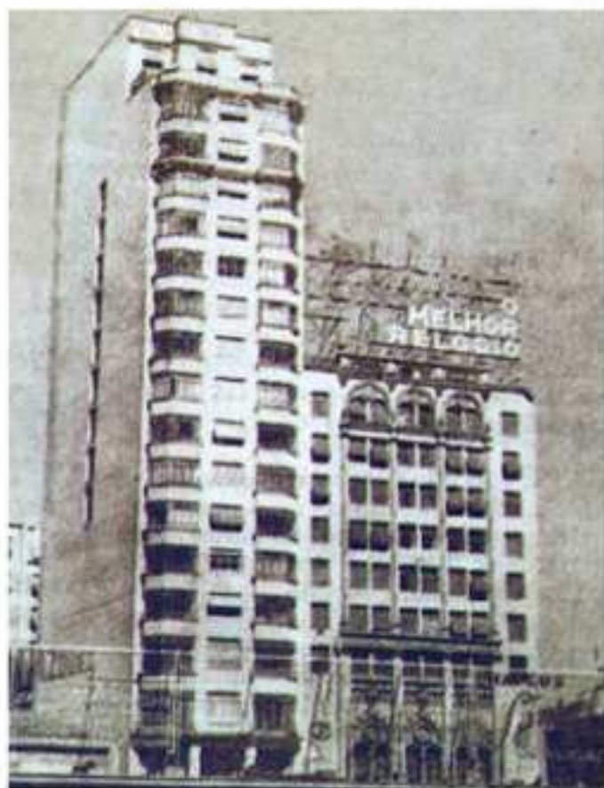
Sede atual em construção - 1960
